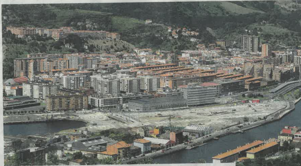
Vista de la península de Zorrozaurre, que se convertirá en isla a finales del próximo año.
